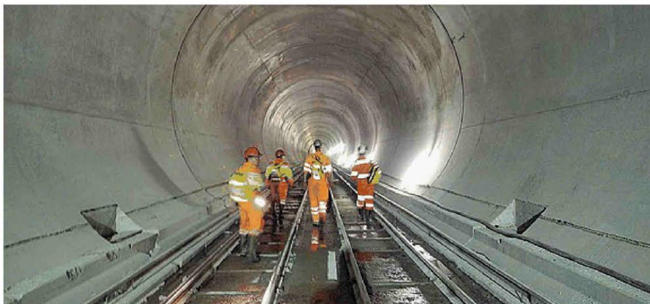
Il tunnel ferroviario del Gottardo è una delle opere alla quale la ditta Pizzarotti ha lavorato. In particolare la ditta ha realizzato la galleria di base, detta galleria Sedru
